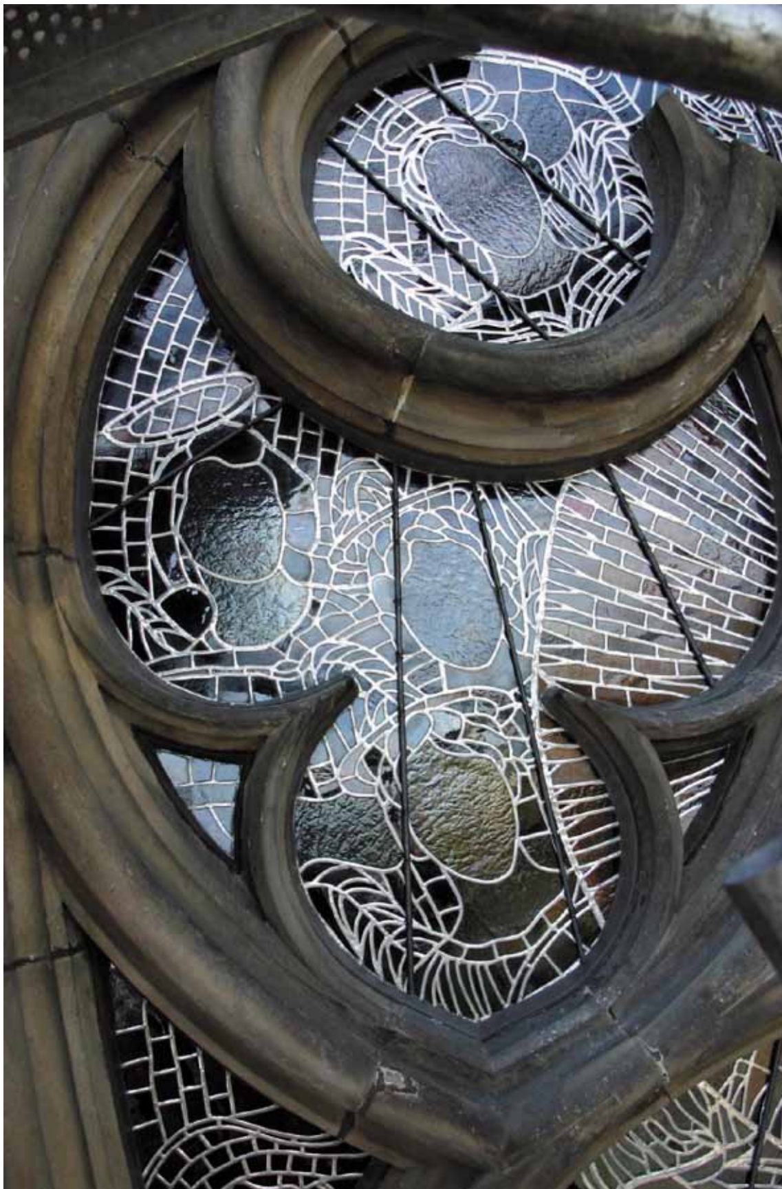
Ukázka osazování zrestaurovaných výplní kružby. Detailní záběr na část osazené kružby. Pohled z exteriéru.
