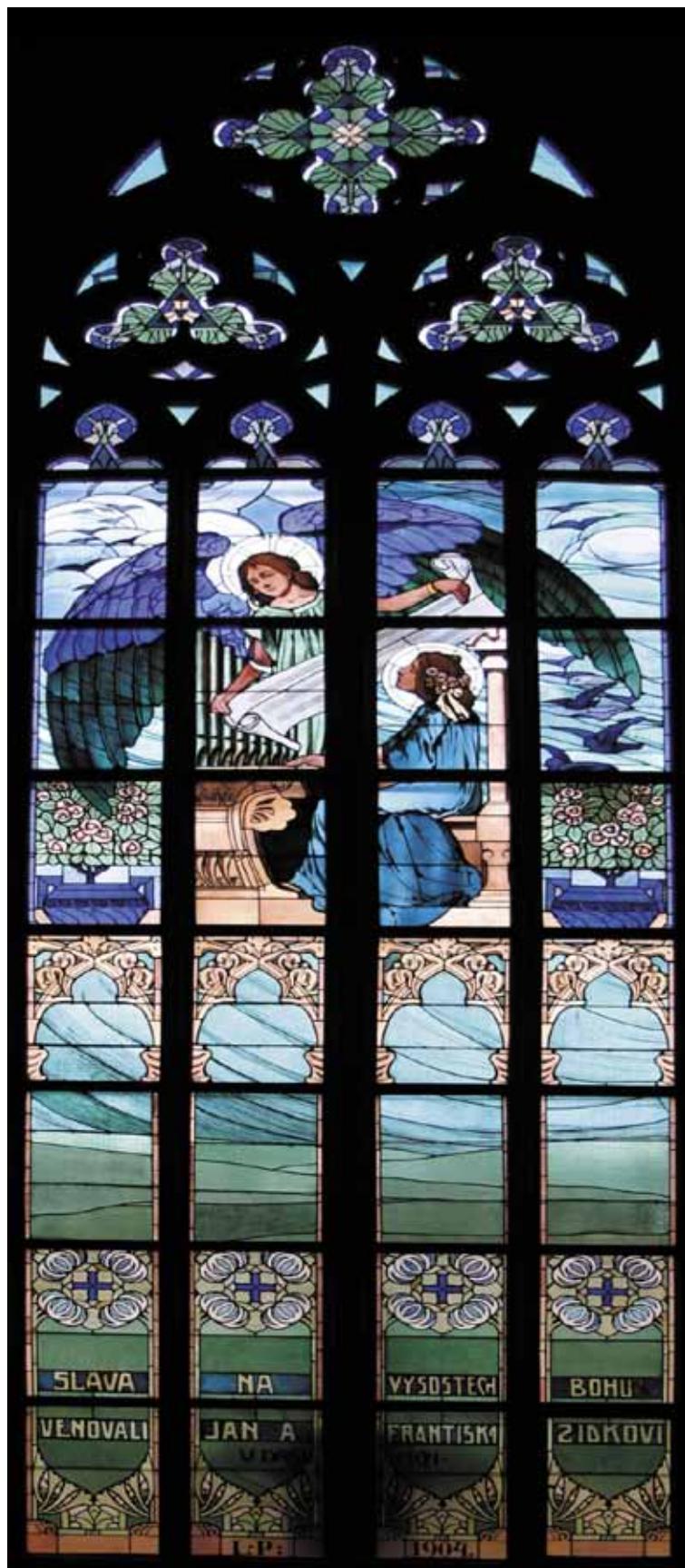
Zrestaurovaná a nově osazená vitraj západní strany chrámu sv. Vavřince ve Vysokém Mýtě.
