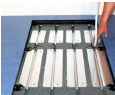
4. Verlegen der Medienleitungen.
