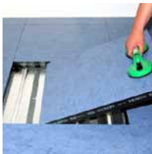
1. Aufnehmen mit Hebwerkzeug, einseitig angesetzt.
