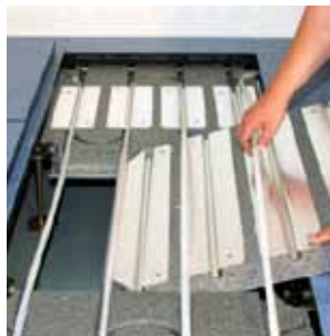
2. Heizleitungen ausclipsen. Wärmedämmkassette einfach mit der Hand schräg nach oben herausnehmen. Elektrokabel sind jetzt zugänglich.
