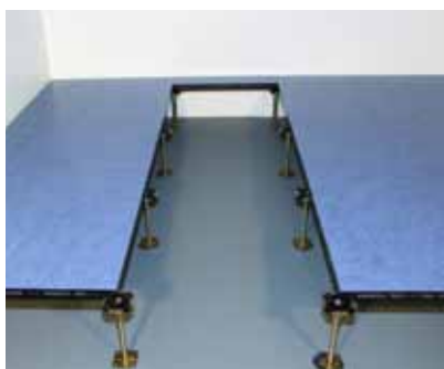
1. Aufnahme von Plattenreihen für die Montage der Fußbodenheizung.
