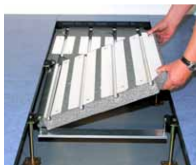
3. Einlegen der Wärmedämmkassetten mit Wärmeleitblech.
