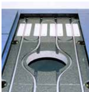
3. Steckdosenplatten können nachträglich in ihrer Lage verändert werden. Es ist dann lediglich das Wärmeleitblech herauszunehmen und die Isolierung entsprechend der Steckdosengröße auszuschneiden oder umzulegen.
