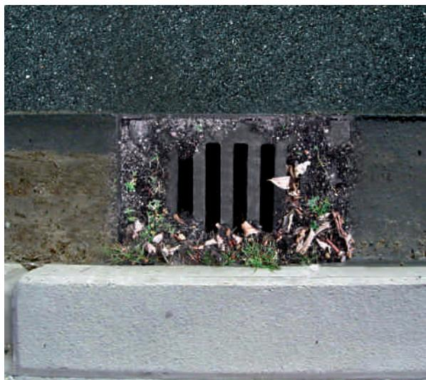
I přes velké vtokové průřezy jsou často volné průřezy mezi spodní stranou roštových tyčí a tělesem příliš malé a krátkodobě upcpávají široké úseky odtoku
