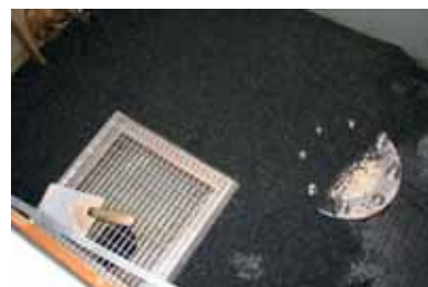
Zkušební instalace s odvodňovací výztuží a ložem z drceného štěrku před přístupovým rámem k výstupu
