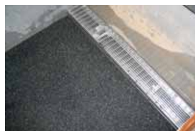
Štěrkové lože se štěrskem drceným na velikost 2/5 mm
