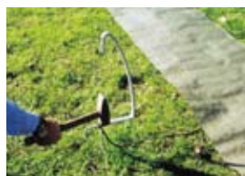
Zatlučení kotvícího háku
