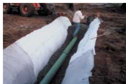
Jednotlivý vsakovací příkop
