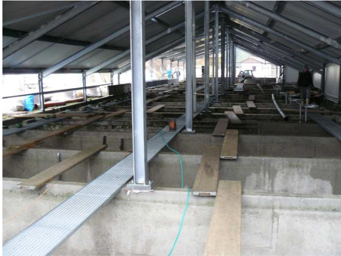
Obr. 4. Přístavba zastřešení u RAS v Mlýnech u Vimperka
