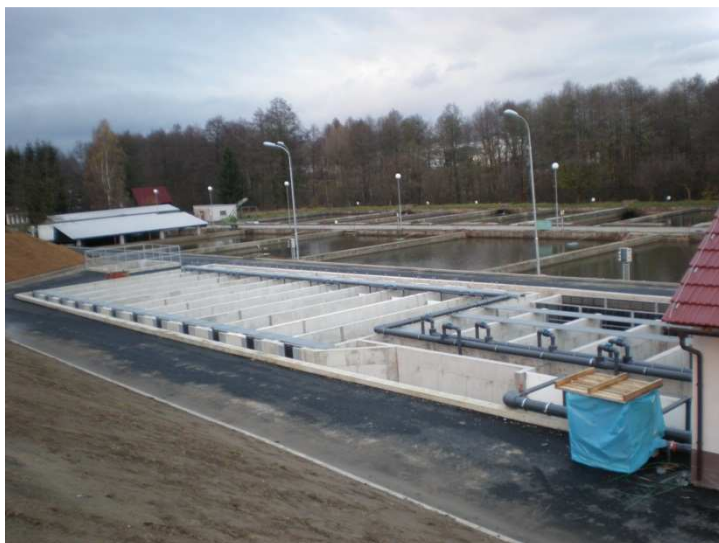
Obr. 6. Nově vybudovaný RAS dánského typu pro chov sňů a lososovitých ryb ve Žďáře n/Sázavou
