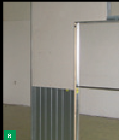
6 Opláštění pouzdra deskou SDK
