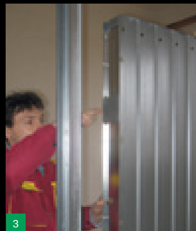
3 Připevnění pouzdra ke konstrukci
