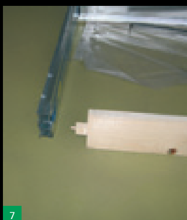
7 Nasazení a upevnění stojny
