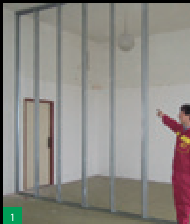
1 Příprava profilů SDK pro usazení pouzdra
