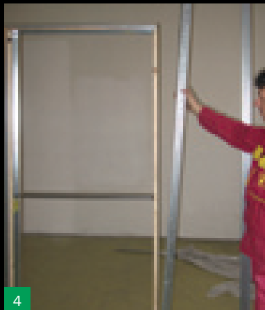
4 Montáž protilehlé strany konstrukce
