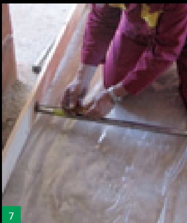
4 Montáž horní lišty s kolejničí
