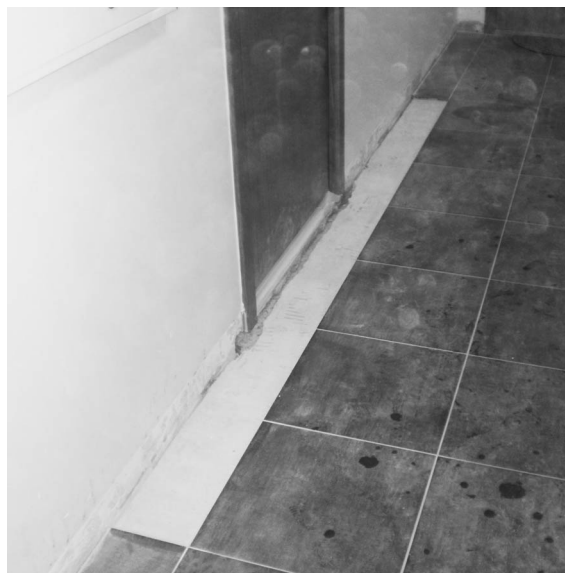
Obr. 2 – Vstupní dveře do bytu, odstraněná nášlapná vrstva a oddělena roznášecí vrstva
