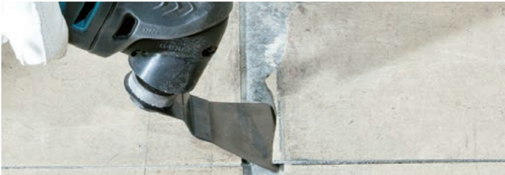
Odsekávání dlaždic B-21456
