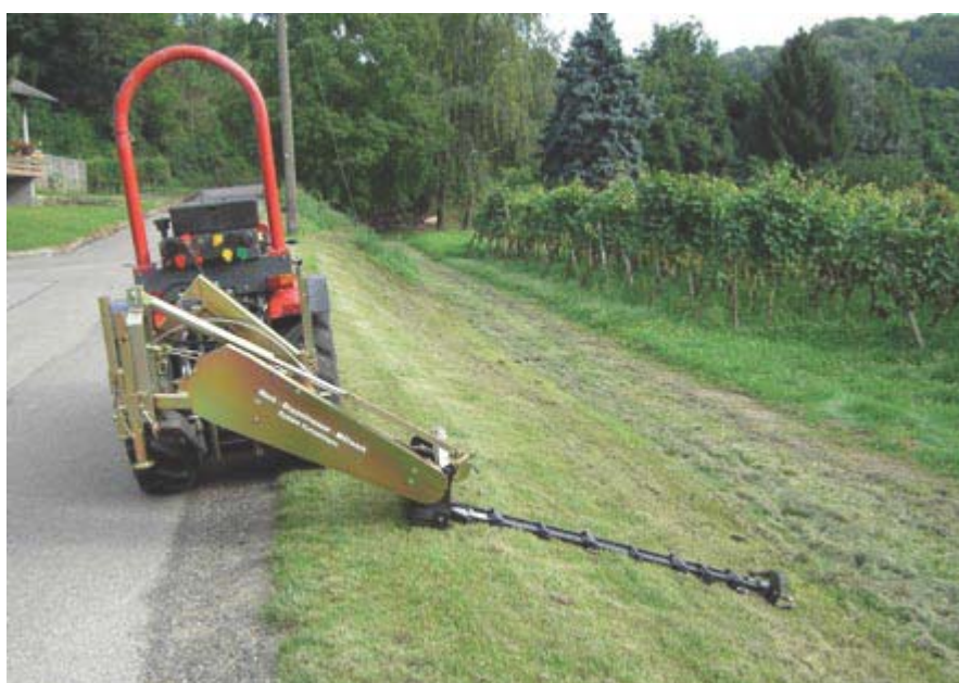
Sečení svahů strojem Systemtechnik KUNZELMANN
