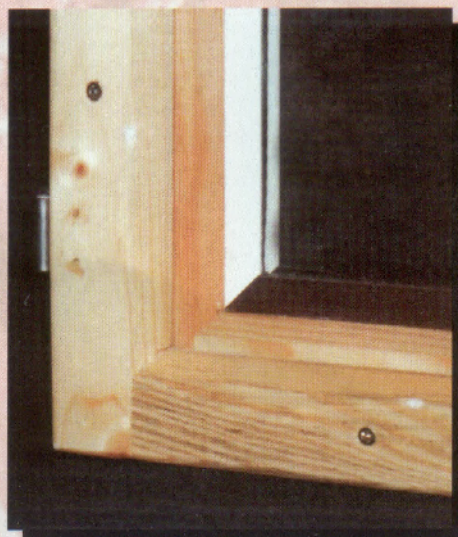
Pohled na vnitřní stranu
