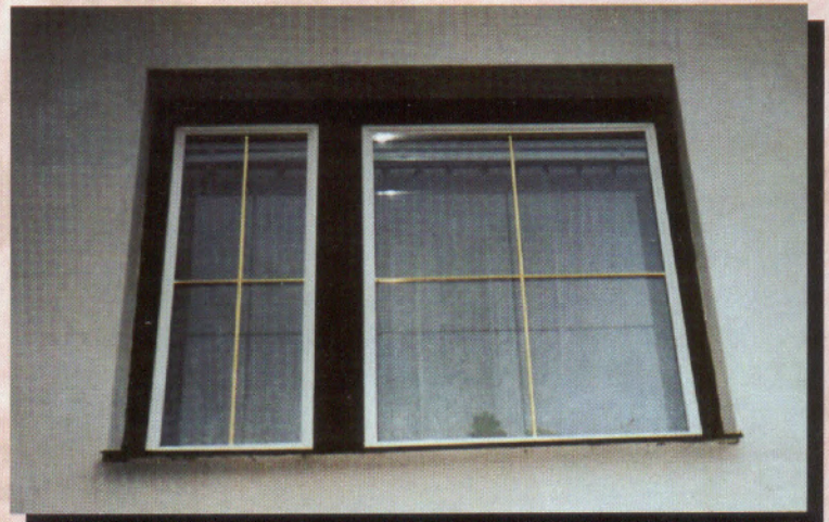
Příklad renovovaného okna (zabudovány ozdobné mřížky)
