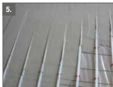
5. Der Anhydrit-Fließestrich wird vergossen. Durch eine vollkommene Ummantelung der Rohre ist eine optimale Temperaturübertragung sichergestellt.
