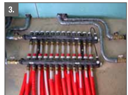
3. Die Heizkreisverteiler können platzsparend im Hohlraum liegend auf der Rohbetondecke montiert werden und sind später über Revisionsöffnungen zugänglich. Die Anbindeleitungen werden isoliert im Hohlraum geführt.
