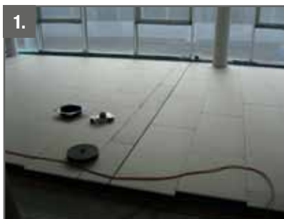
1. Die Unterkonstruktion des Mero Hohlbodens Combi A wird in gewohnter Weise mit Stahlgewindestützen im 60er Raster und nicht-brennbarer Trägerplatte ausgeführt.
