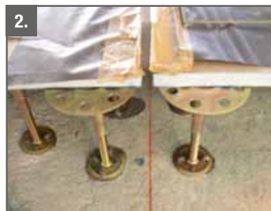
2. Damit unterschiedlich beheizte Flächen sich separat ausdehnen können wird die Konstruktion komplett getrennt.
