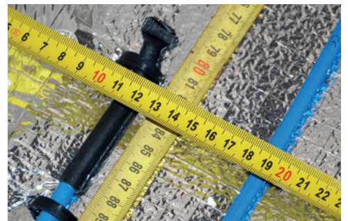
detail zaměření koncovky dvoužilového topného kabelu
