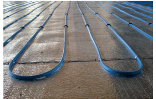
instalace dvoužilového topného kabelu před zalitím anhydritem
